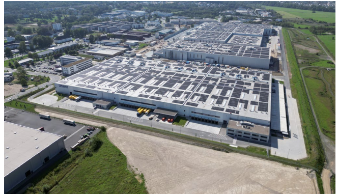
VGP Park Giessen am Alten Flughafen
